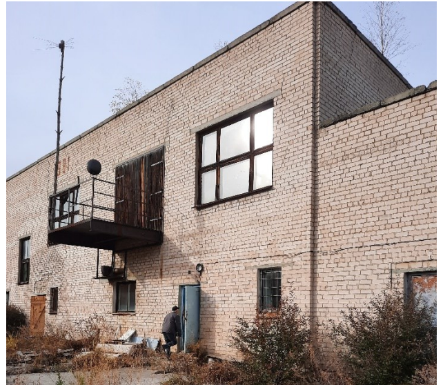
Здание СОЖ – не действующее.
