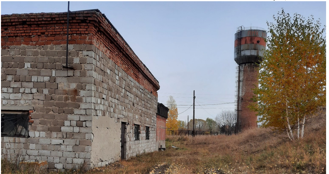
Насосная станция II-ого подъема, не действующая башня и подземные РЧВ.
